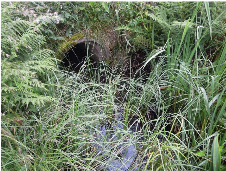
Figur 11. Utløpet mot Figgjoelva fra rør under Figgjoveien/Jernbanelinja. Sakteflytende vann, tett vannvegetasjon og mudderbunn gjør bekkesiget mindre egnet som leveområde for elvemusling.
